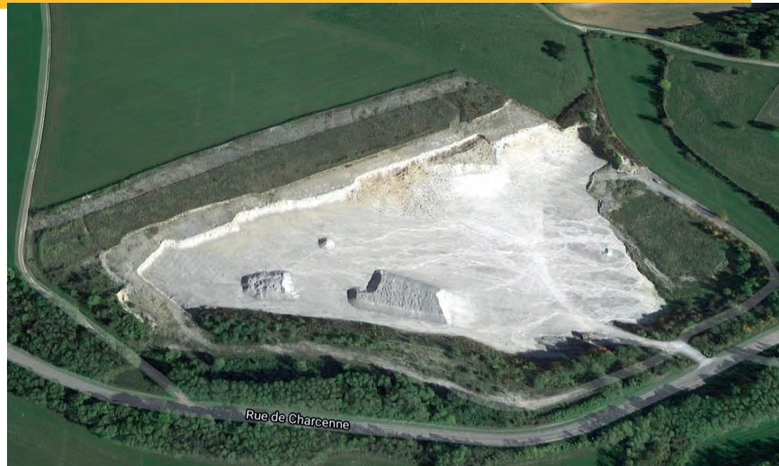
INSTALLATION MOBILE DE CONCASSAGE – CRIBLAGE CARRIERE DE CALCAIRE DU COLOMBIN AVRIGNEY-VIREY (70)
