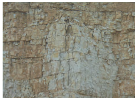
Vue du front de taille après un tir de mine
