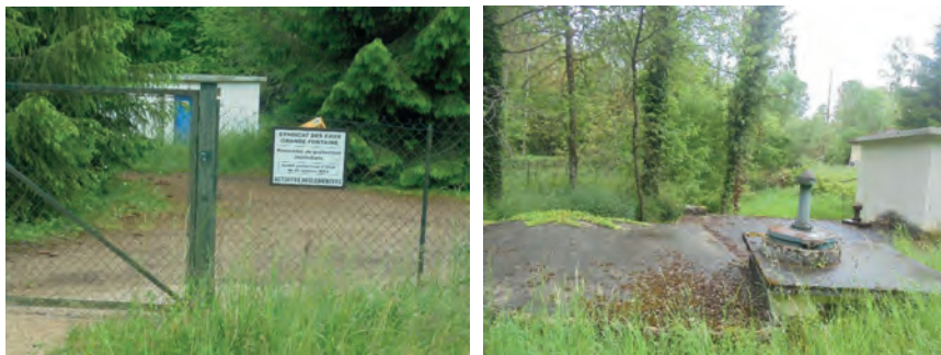
Captage de la source de la Grande Fontaine (inexploitée)
